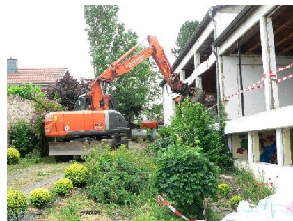
Abbruch des alten Gemeindehauses
