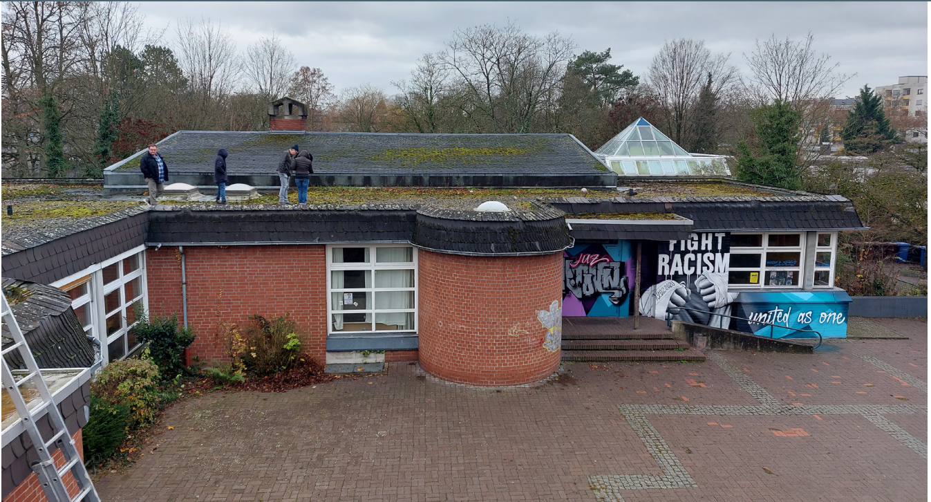
Auf der Suche nach der undichten Stelle auf dem Dach des Jugend- und Gemeindezentrums
